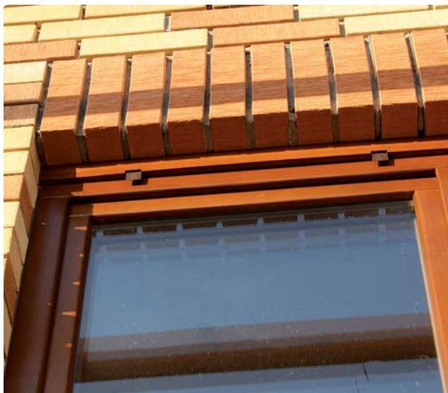
Внешний вид кладки с использованием перемычек BRICKO
