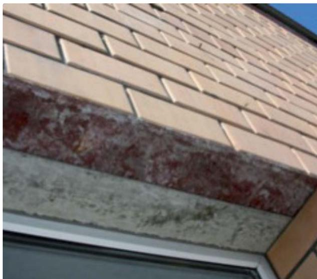
Внешний вид кладки без применения перемычек BRICKO
